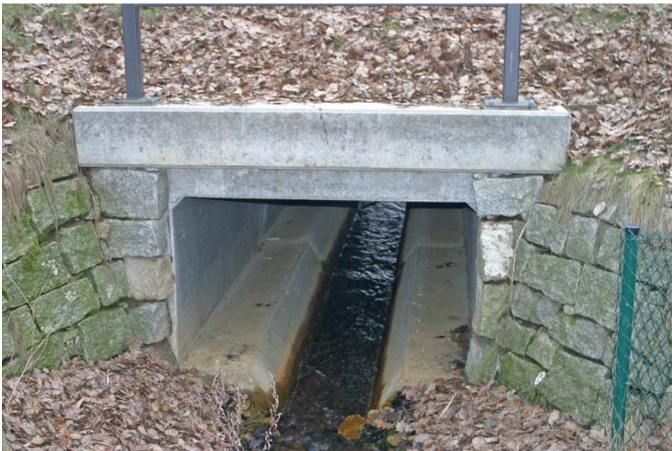
Durchlass an der K 8471 bei Förstgen
